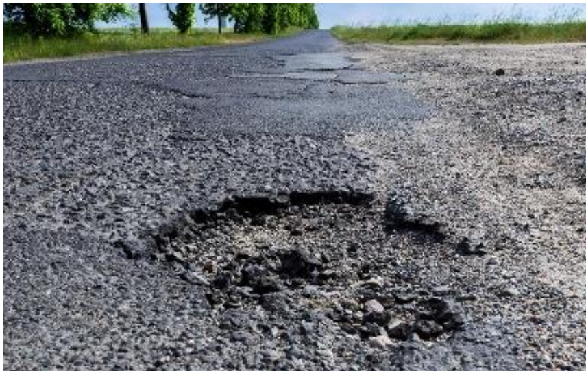
Abbildung 4: Schadensbild-Beispiel (Ausmagerung Ausbruch)
